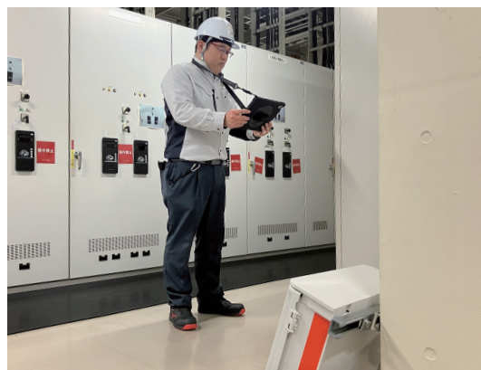
現場に設置されたWi-Fi通信パッケージ(右下)の利用シーン
